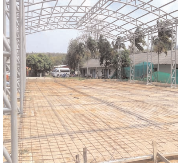
Och bakom det gröna skynket döljer sig detta - snart är det dags att gjuta golvet.
